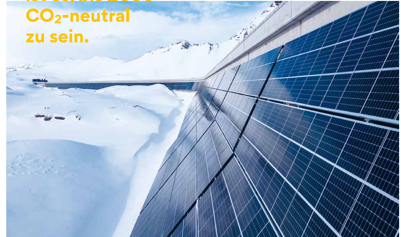
Die 2,2-Megawatt-Solaranlage an der Muttsee-Staumauer wurde 2021 gebaut und ist die grösste im Alpenraum. Jährlich produziert sie 3,3 Millionen Kilowattstunden Strom, der von Denner für 20 Jahre bezogen wird.
