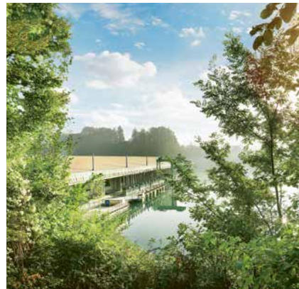
Centrale elettrica di Mühleberg a Spiez.
