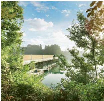
Kraftwerk Mühleberg in Spiez.
