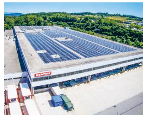
Sul tetto della centrale di distribuzione di Lyss è stato installato il primo impianto fotovoltaico di Denner.
